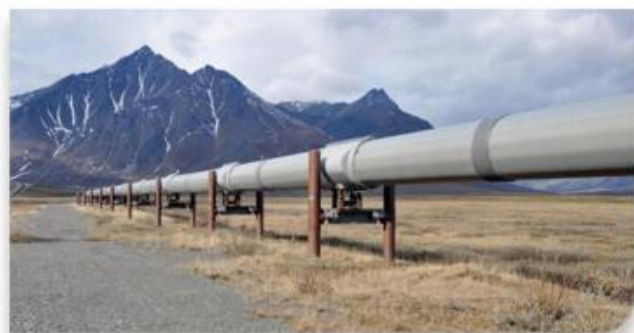
■ 国新国际出资参与的某天然气管道项目。
